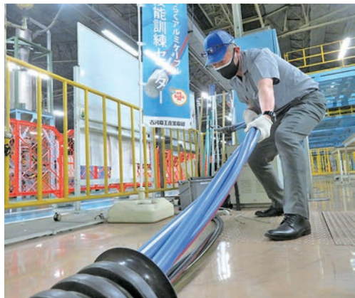
「らくらくアルミケーブル」の施工作業性を体感できるコーナー④と接続作業中のアルミ製建設用ケーブル
